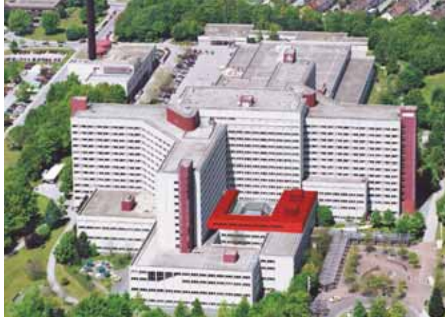
In dem roten Aufbau werden die Interims-OPs untergebracht. Foto: Poppe
