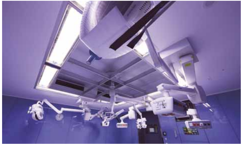
Bei den neuen OP-Leuchten sind die Helligkeit und Farbe des Lichts verstellbar, wodurch sich bestimmte anatomische Strukturen besser erkennen lassen.
