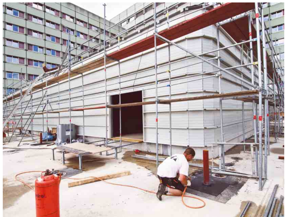
Fertiggestellt ist der neue Dach-OP-Bereich mit zusätzlichen sechs neuen Sälen.
