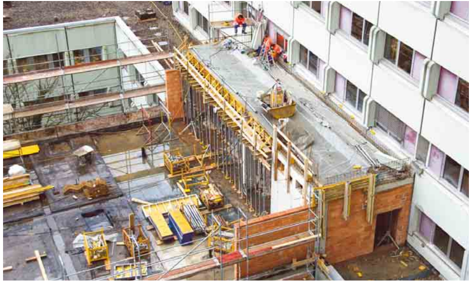
Rohbau: Die neuen OP-Säle wurden auf das Dach der Eingangshalle gesetzt. Sie sind über kurze Gänge mit der Zentralen OP-Abteilung verbunden.
