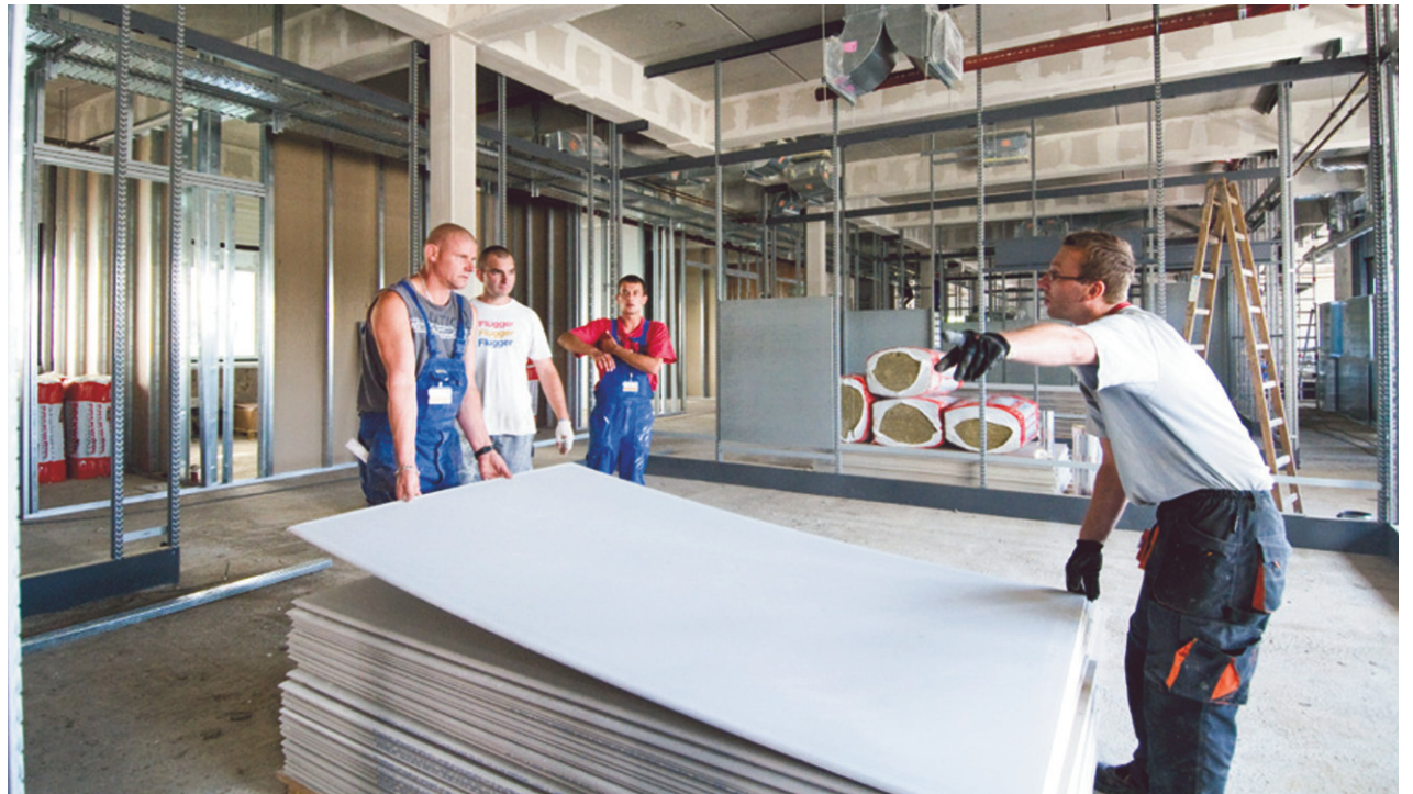
Auf vollen Touren laufen die Innen-Ausbauarbeiten in dem neuen OP-Trakt.
