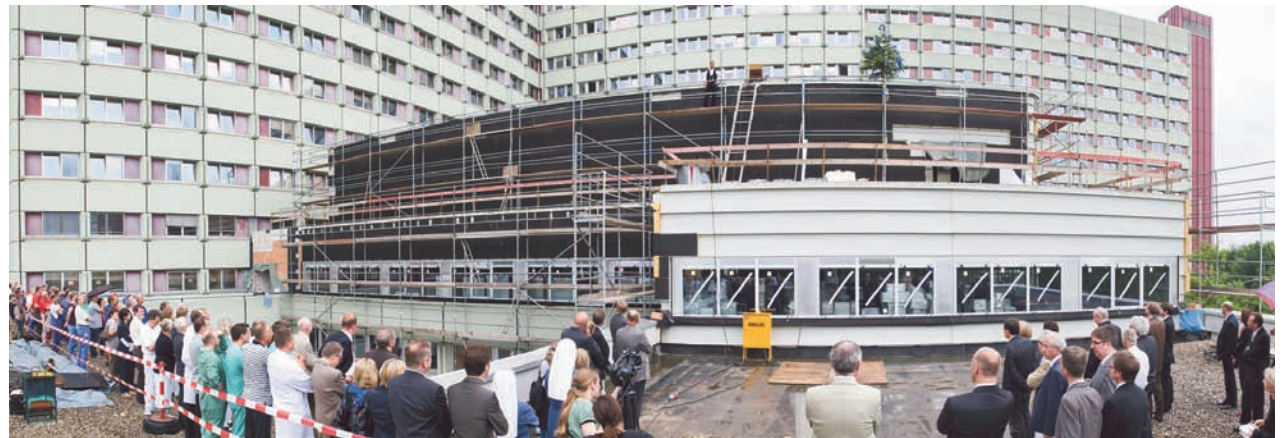
Der Eingangshalle und dem Verwaltungstrakt aufs Dach gesetzt wurde der mit rund zehn Millionen Euro geförderte Neubau, in dem sechs Operationssäle samt Nebenräumen Platz finden werden. Fotos: Wirth
