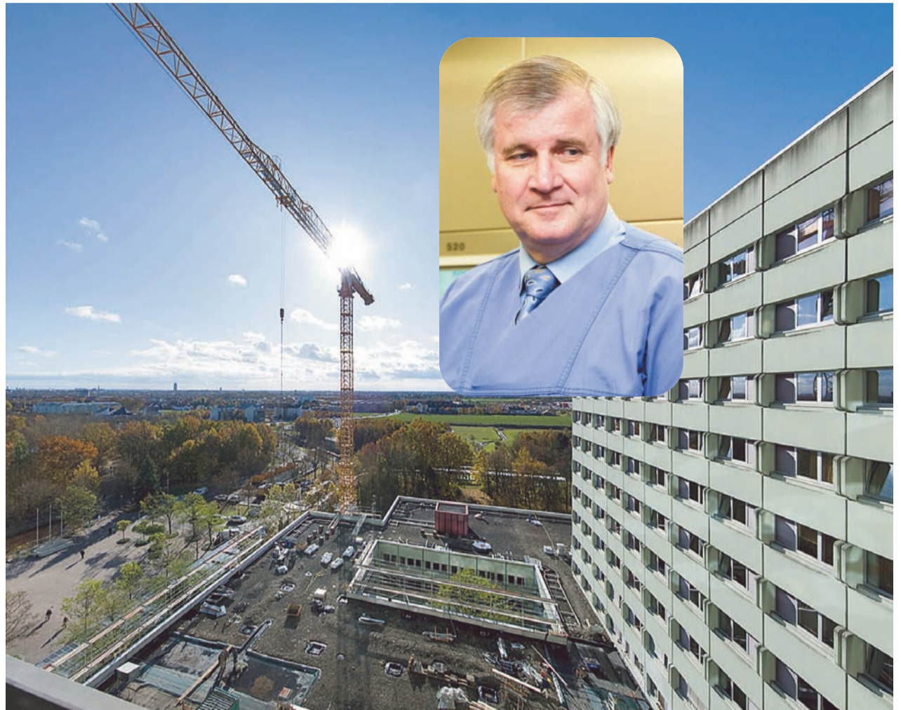
Längst begonnen hat die Generalsanierung – hier die Baustelle für sechs Operationssäle.
